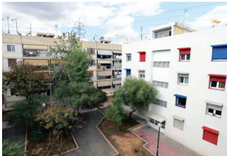
Σε ένα από τα κτίρια έχουν ήδη πραγματοποιηθεί παρεμβάσεις και έχουν τοποθετηθεί νέα κουφώματα με ενεργειακά υαλοστάσια και εξωτερική θερμομόνωση.
